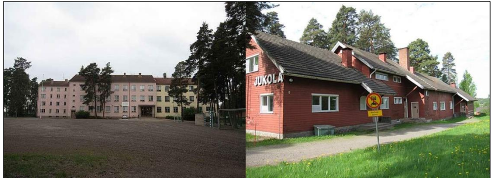
Kauttuan koulu ja Jukola, © Euran keskustan osayleiskaava-alueen rakennusinventointi 2013.
