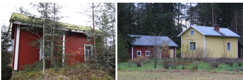
Kuva 10. Salminen on entinen torppa tai mäkitupa, jonka pieni ja huonokuntoinen asuinrakennus on 1900-luvun alusta. Rakennus on maalattu punaiseksi.
