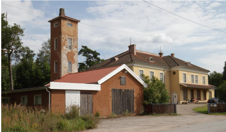
Kuva 14. Kuvan vasemmassa reunassa on Honkilahden VPK:n vanha paloasema ja oikeassa reunassa entinen Honkilahden osuusmeijeri. Paloasema on pieni ja vaatimaton kalustovaja. Siihen kuuluu myös letkutorni. Osuusmeijeri on aumakattoinen, kaksikerroksinen komea, tyyliiltään klassistinen rakennus.
