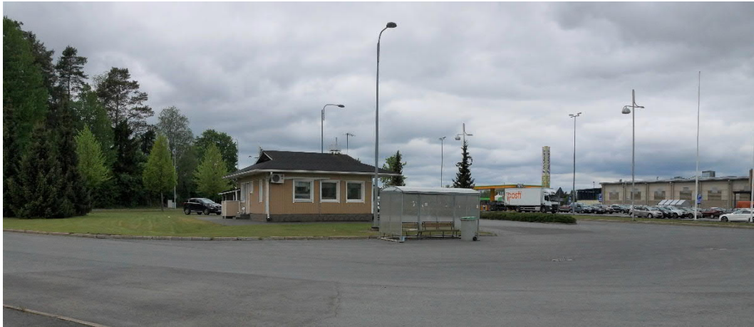
Kuva 6. Matkahuolto Osmantien ja Satakunnankadun välissä. Kuva: Pasi Vierimaa / Sweco, 6/2020.
