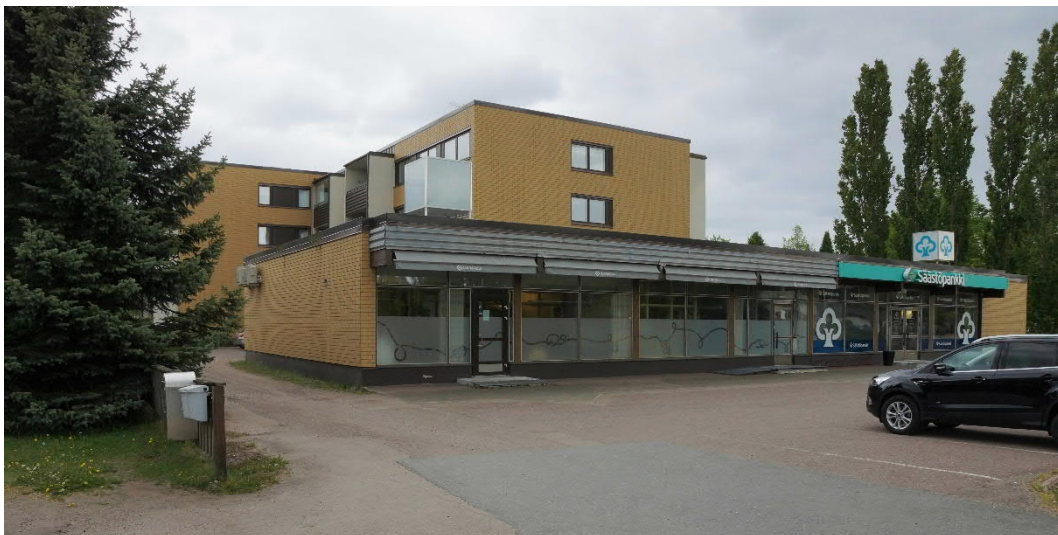
Kuva 12 Eurantien itäpuolella ja Satakunnankadun pohjoispuolella sijaitseva asuin- ja liikeyrakennus. Kuva: Pasi Vierimaa / Sweco, 6/2020.
