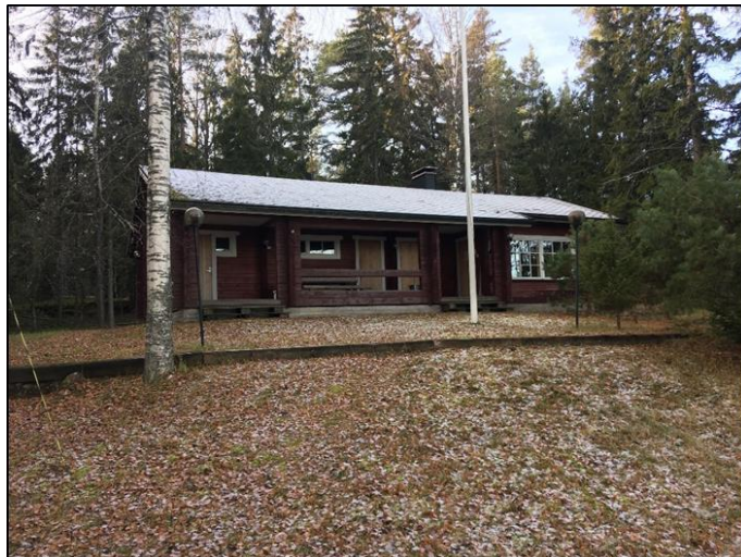
Apetit Oy:n käytössä oleva saunarakennus suunnittelualan koillisosassa.
