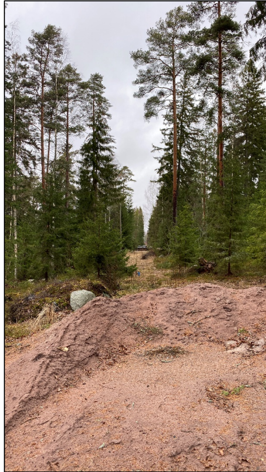
Suunnittelualan metsää. Kuvassa vanhan sähkölinjan sijainti. Samaan tilaan on sijoitettu tällä hetkellä sähköverkon maakaapeli ja vesihuollon verkostot.
