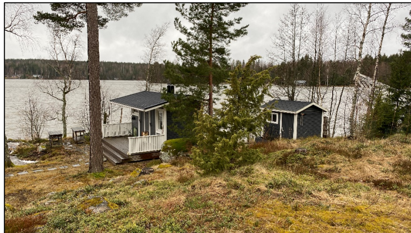
Sauna- ja talousrakennus kiinteistöllä 50-406-13-73 SUVIRANTA.
