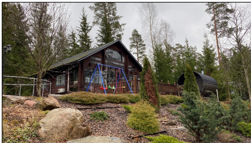
Vapaa-ajan asuinrakennus kiinteistöllä 50-406-13-19 MÄNTYLÄ.
