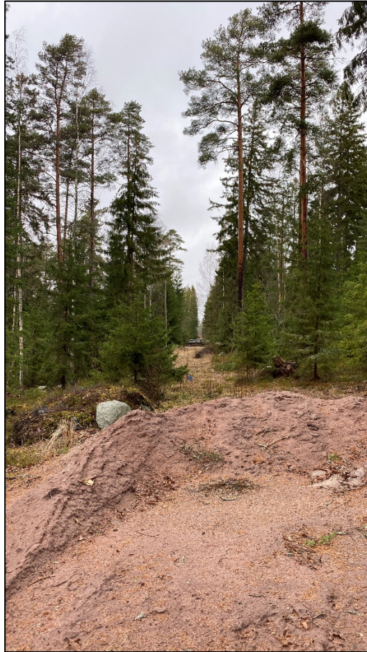
Suunnittelualueen metsää. Kuvassa vanhan sähkölinjan sijainti. Samaan tilaan on sijoitettuna tällä hetkellä sähköverkon maakaapeli ja vesihuollon verkostot.
