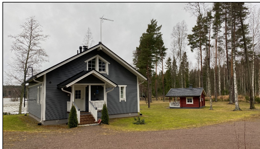
Vapaa-ajan asuinrakennus ja saunarakennus kiinteistöllä 50-406-13-71 NESTORILA.
